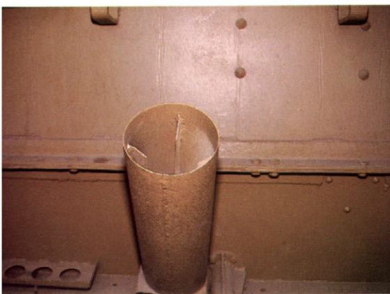
垂直型エグゾーストパイプの先端。 Top of vertical exhaust pipe.
